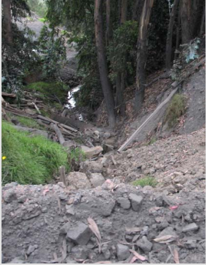
Impacto en caudales por mal manejo estériles
